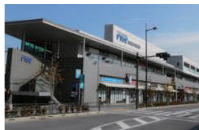
二子玉川駅バスターミナルにある「二子玉川交番」から、道路を挟んで向かいにある2階建ての建物です。
